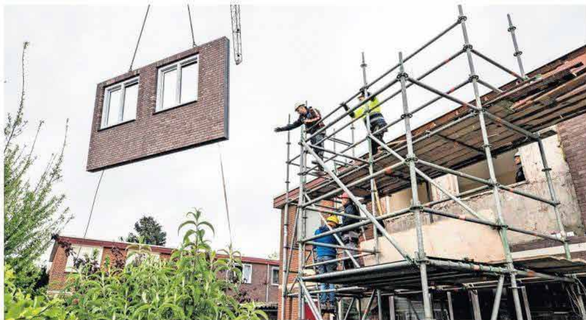
▲ Renovatie van Woonbron-huizen in de Tuinenhoven in Rotterdam-Zuid. De problemen in de wijk waren zo groot dat er een landelijk herstelprogramma nodig was om de achterstanden in te lopen. FOTO: WOONBRON
